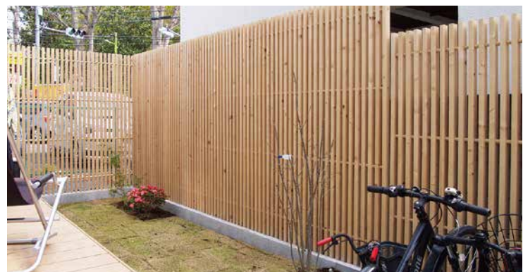
30×60° 角 格子 H2000 型枠ブロックの基礎に施工 無色透明の防腐薬剤を使用
