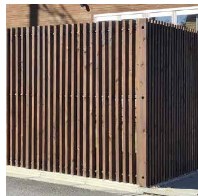
42×85° 角 格子 H1800 溝掘り施工
