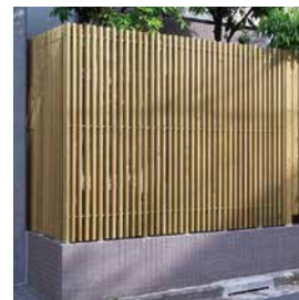
布基礎（既設）上に
