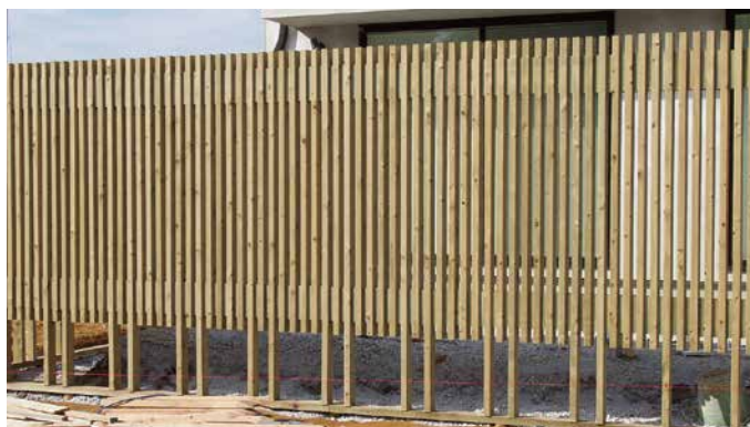
42×85° 角と 30×60° 角 小間入格子 H1680 フェンスを立てた後に、型枠を組んでコンクリート流し込み (工事中写真)
