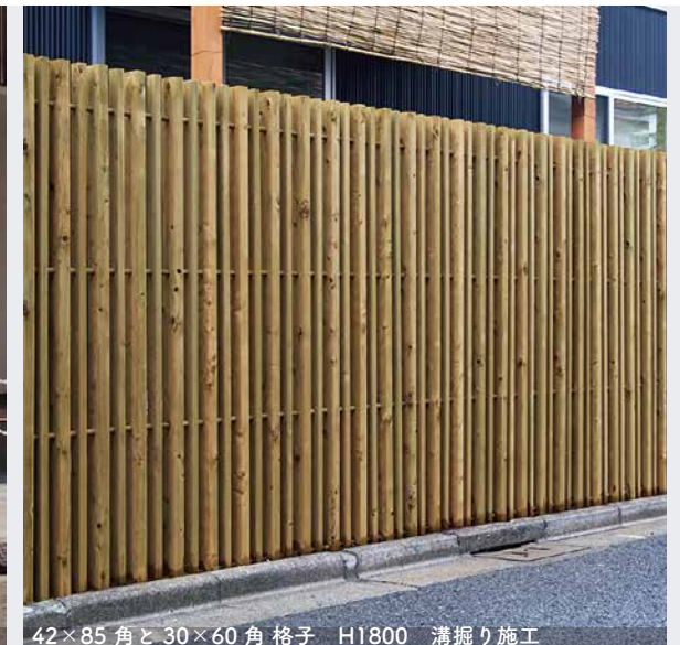
42×85 角と30×60 角 格子 H1800 溝掘り施工
