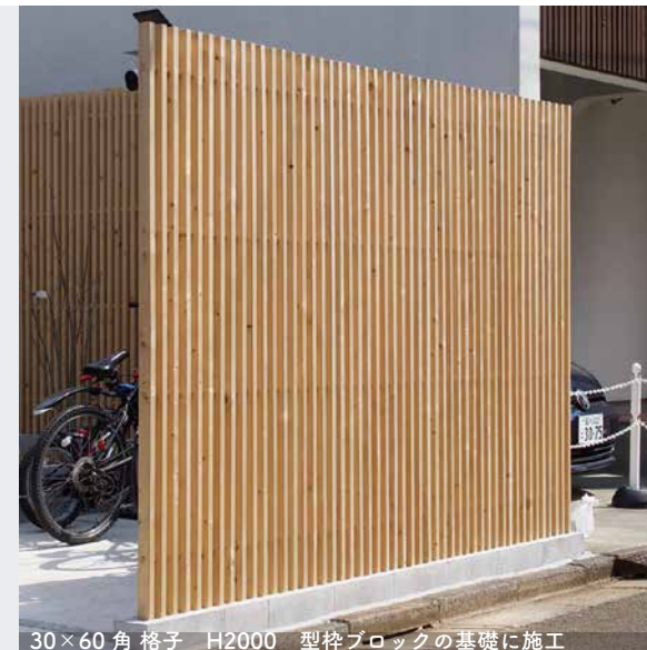
30×60 角 格子 H2000 型枠ブロックの基礎に施工
