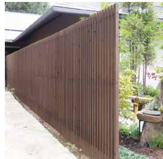
42° 角 格子 H1800 隣地境界際に溝掘り施工、施工前に塗装
