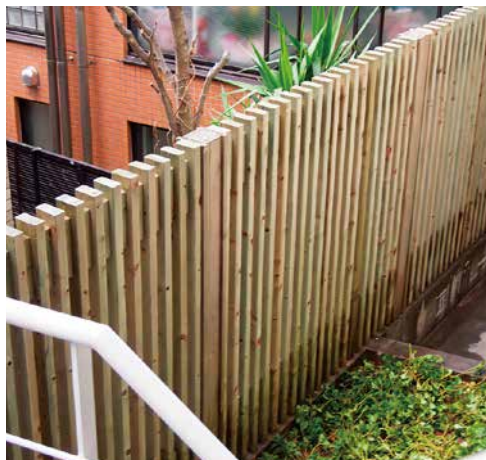
42×85° 角と 42° 角 小間入格子 H1600 既設基礎の上に既存の支柱を利用して施工
