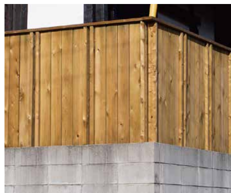
42×85° 角と 30×120° 板の目隠しフェンス H1200 既設の土留めブロックの上に ストレートピン工法で設置
