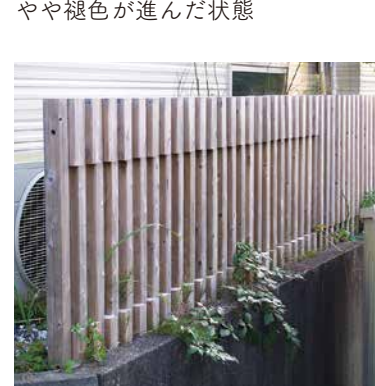
旧仕様）56° 角 目隠し 風穴あり H800 穴掘り施工 丸穴を偏心させて凹凸のデザイン すでに褪色して灰色に
