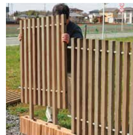
コンクリートブロック上に
