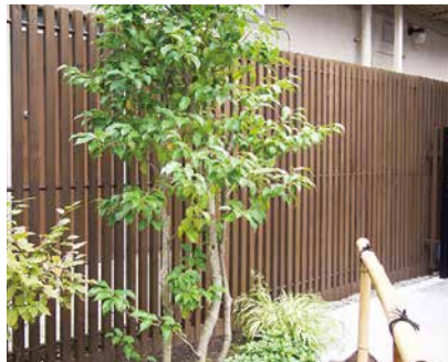
42° 角 格子 H1800 隣地境界際に溝掘り施工、施工前に塗装
