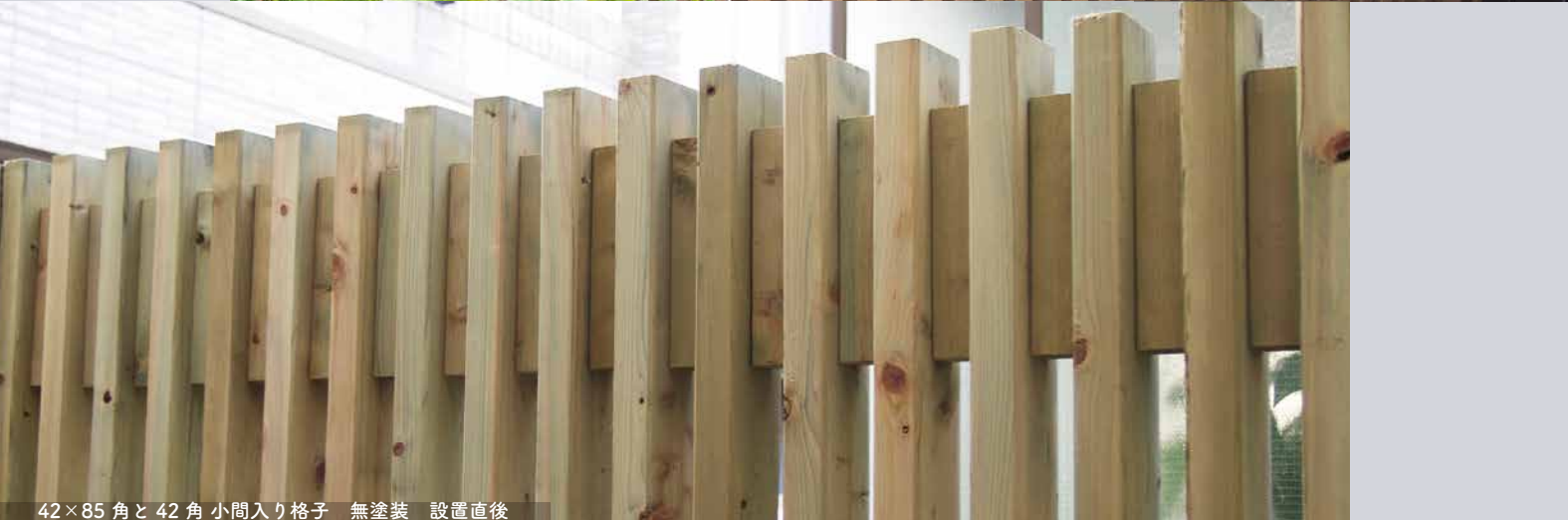
42 角 格子 設置工事前に油性ステインで塗装
