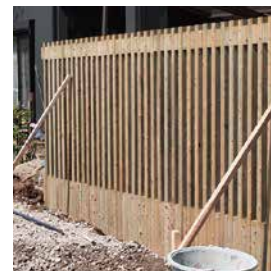
地面に溝掘り
