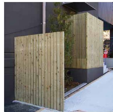
手前）42×85° 角 平並べ 目隠し H1800 コンクリート土間に埋め込み（工事中写真） 後ろ）30×60° 角 格子とのコンビ H1800
