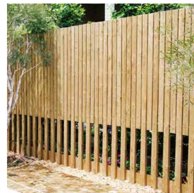
42×85° 角 平並べ 目隠し 風穴あり H1800 溝掘り施工 やや褪色が進んだ状態
